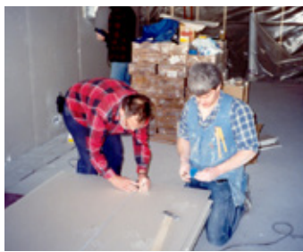
Búið að einangra og setja plastfilnu. Verið að klæða vegg með gísploötum.
