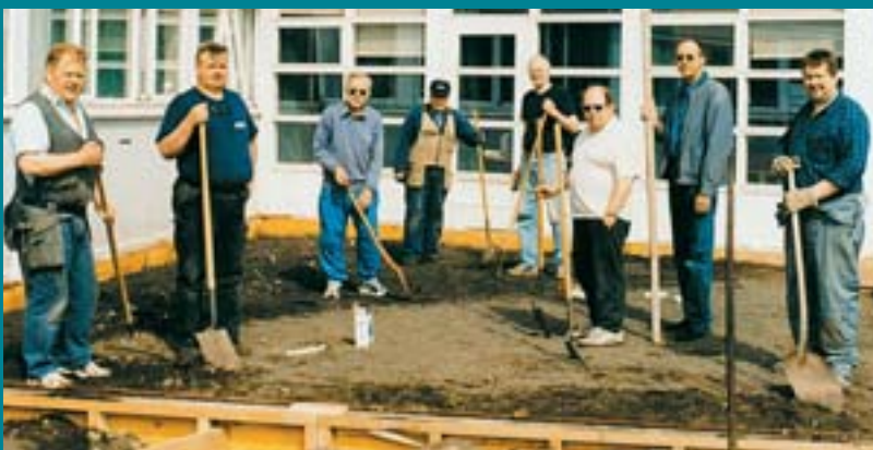
Félagar úr Lionsklúbbi Akureyrar vorðu hluta úr deginum á annan í hvítasunnu við að undirbúa undir steypulögn þar sem á að koma sólpallur fyrir heimilisfólkið á Seli, hjúkrunardeild við Fjórðungs-sjúkrahúsið. Árlega í júní hefur svo verið farið austur að Ástjörn og hjálpað til við ýmis verkefni þar. F.v. Stefán, Sigurður Elisson, Jón, Magnús, Valdimar, Jakob, Héðinn og Sigurður Halldórsson.
