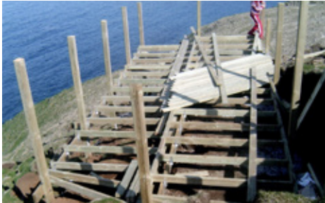
Undirstöður pallins tilbúnar
