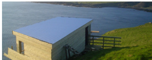
Búið að ganga frá jární á þakið
