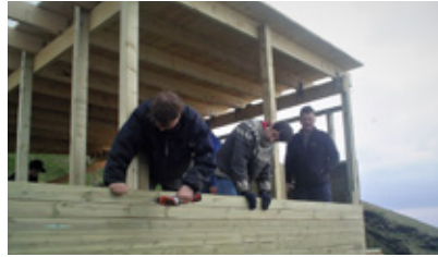
Búið að forma húsið og byrjað að skrúfa klæðningu
