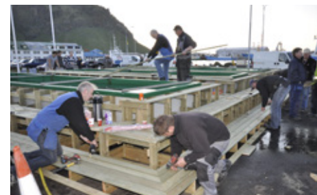
Öll kerin komin á sinn stað og byrjað að klæða göngupalla
